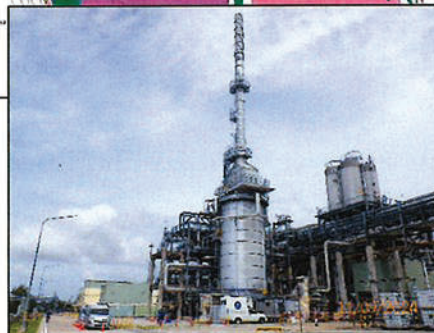
ปล่อง Furnace (F-530) และระบบ CEMS
